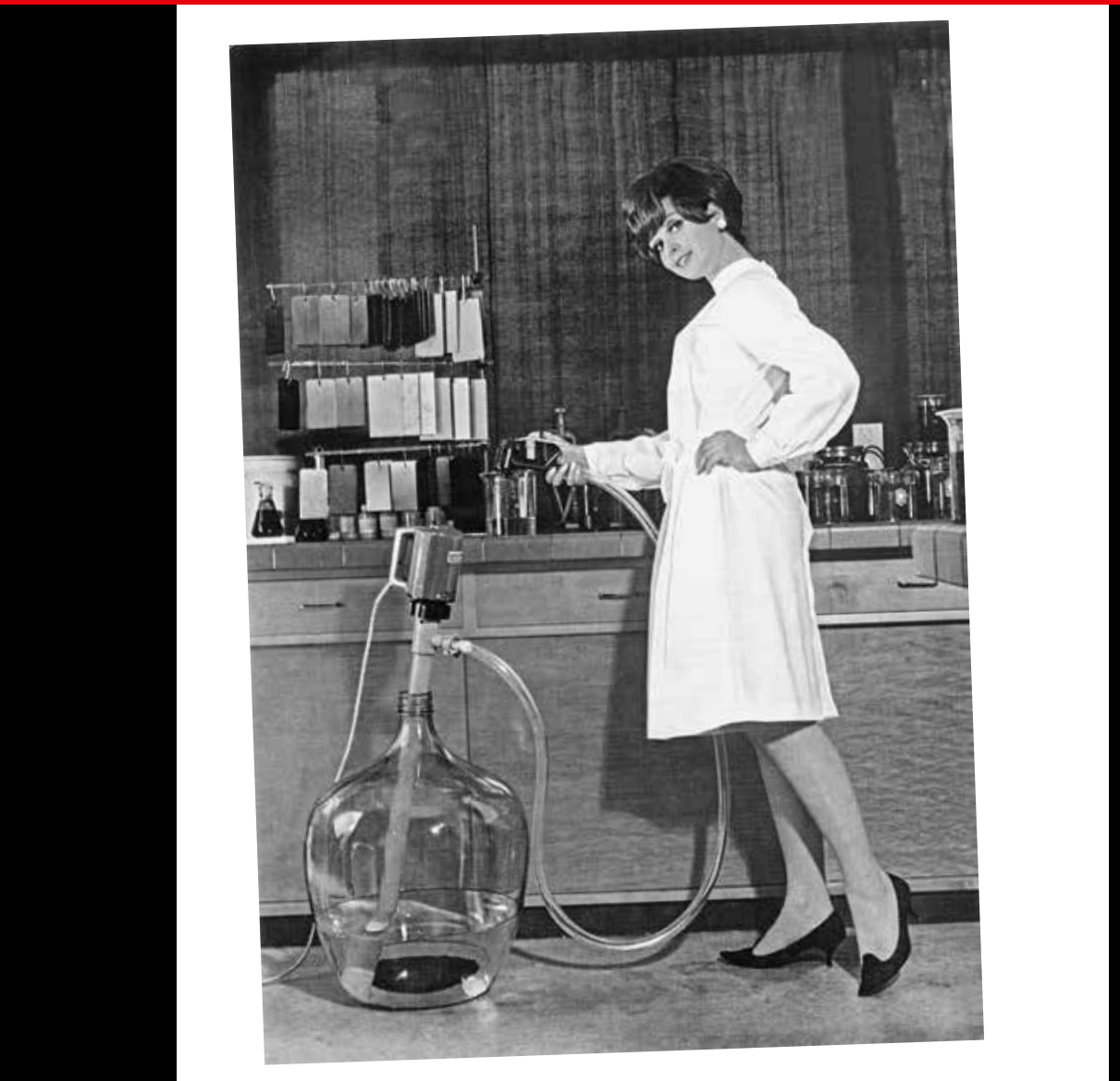
Die FLUX 60 K, eine leichte, handliche Laborpumpe, wurde 1965 auf der Hannover Messe vorgestellt. Für ihre einfache Bedienbarkeit wurde mit dem Bild einer schicken Laborantin geworben.
