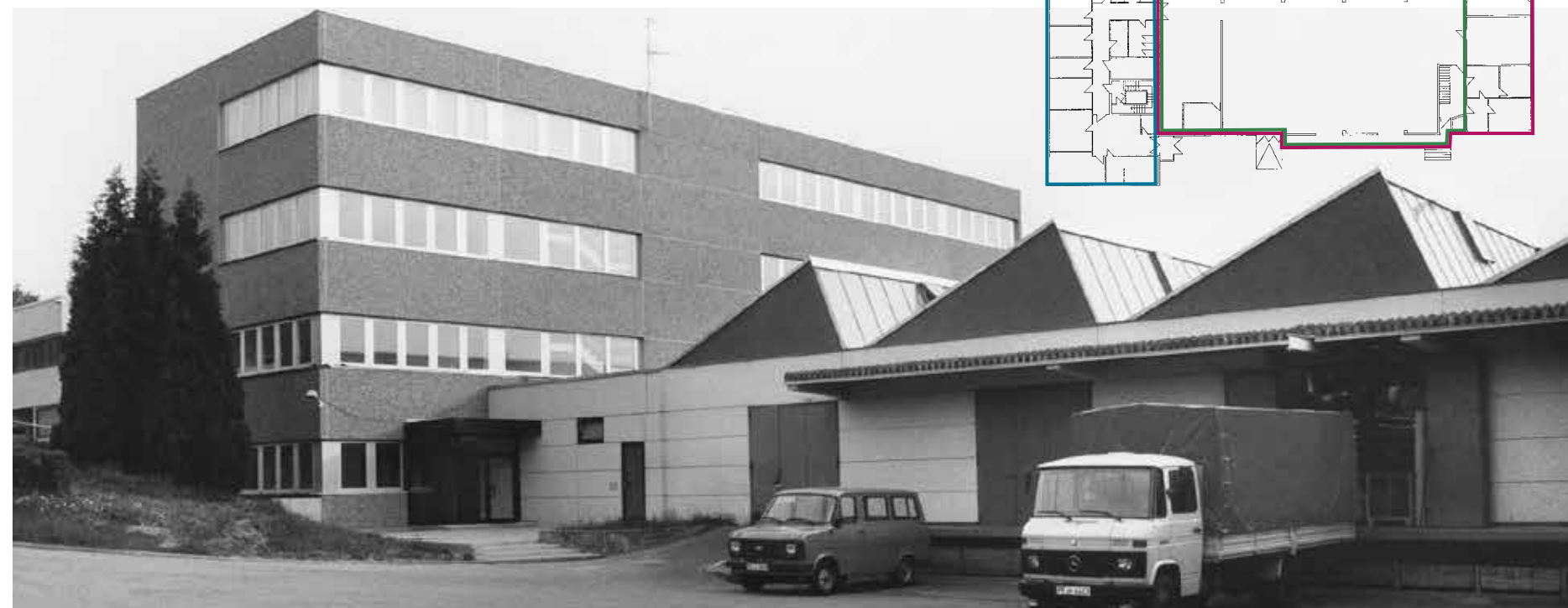
Das Dach der alten Shedbau-Halle wurde umgebaut.
