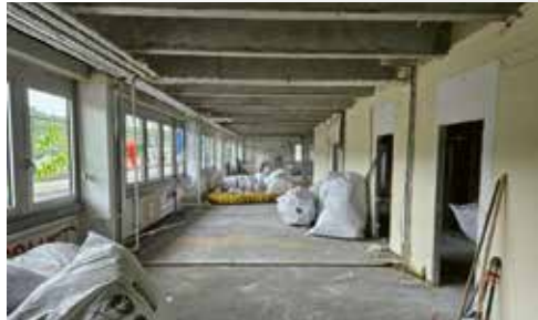
Die Sanierung des Verwaltungsgebäudes kann beginnen, 2024
