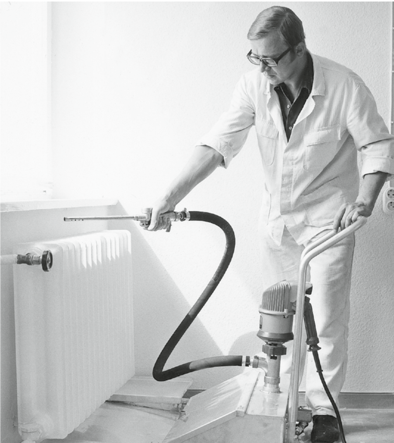
Mit einer explosionsgeschützten FLUX-Pumpe konnten Heizkörper flutlackiert werden.
