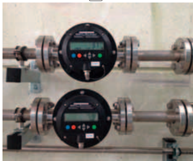
Расходомер FMO 150 с фланцевыми опорами, смонтированный в трубной обвязке.
