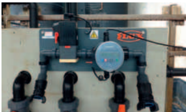
Расходомер FMC 100 вместе с коммутирующим усилителем FSV 100, смонтированные на трубной обвязке системы с полуавтоматическим управлением.
