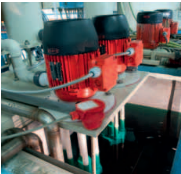
F 716 – Umwälzen von Chemikalien in einem Galvanikbecken.
