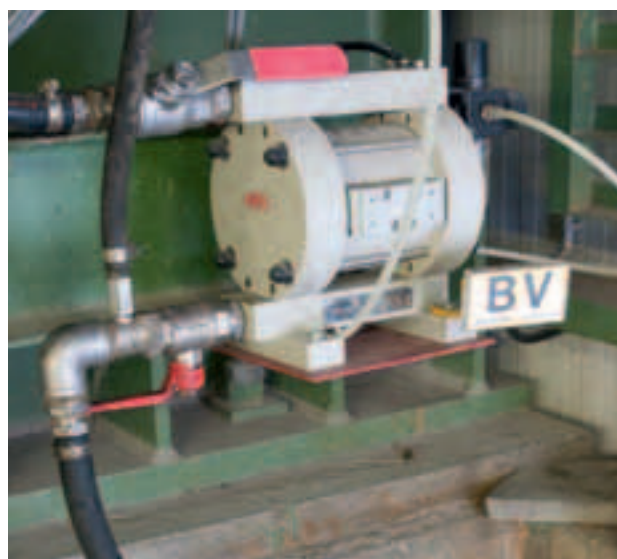
RFM: Fördern von Betonzusatzstoffen aus IBC in Mischturn.
