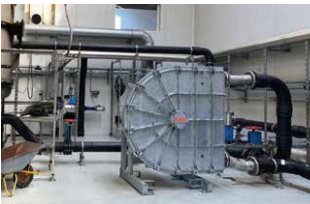
Die FLUX-FHP erreicht Fördervolumen von bis zu 300 m 3 /h.
