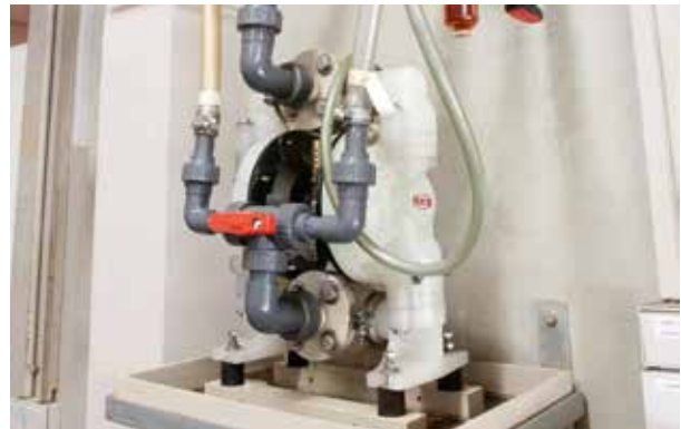
FDM: Fördern von Chemisch Nickel zum Ansatz eines galvanischen Beckens.
