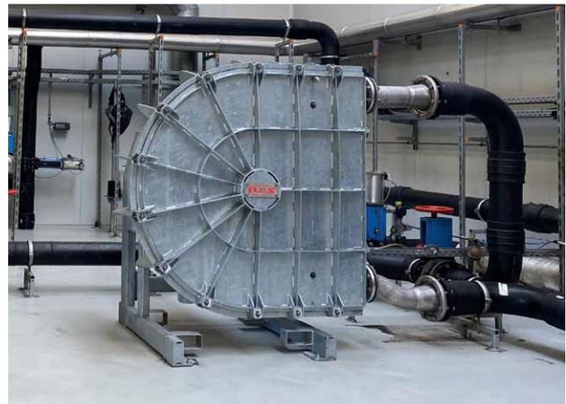
Fördern von feststoffhaltigem Abwasser: die PERIPOWER erreicht Fördervolumen von bis zu 300 m<sup>3</sup>/h.
